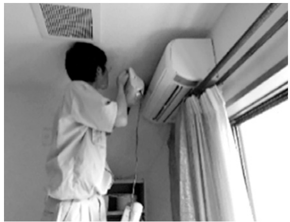
E科 「電ボラ」の様子（エアコンの点検）
